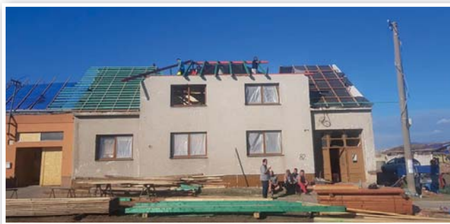
Pomoc členů SDH Jankovice při opravě střechy rodinného domu v obci Hrušky
