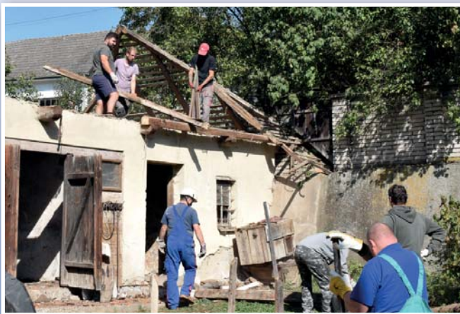
Demontáž střechy – farní dvůr
